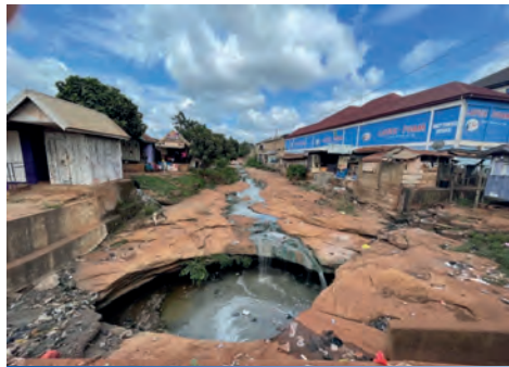
Offener Regenwasser- und Grauwasserabfluss in der Innenstadt von Techiman (Ghana) in den umliegenden Fluss
